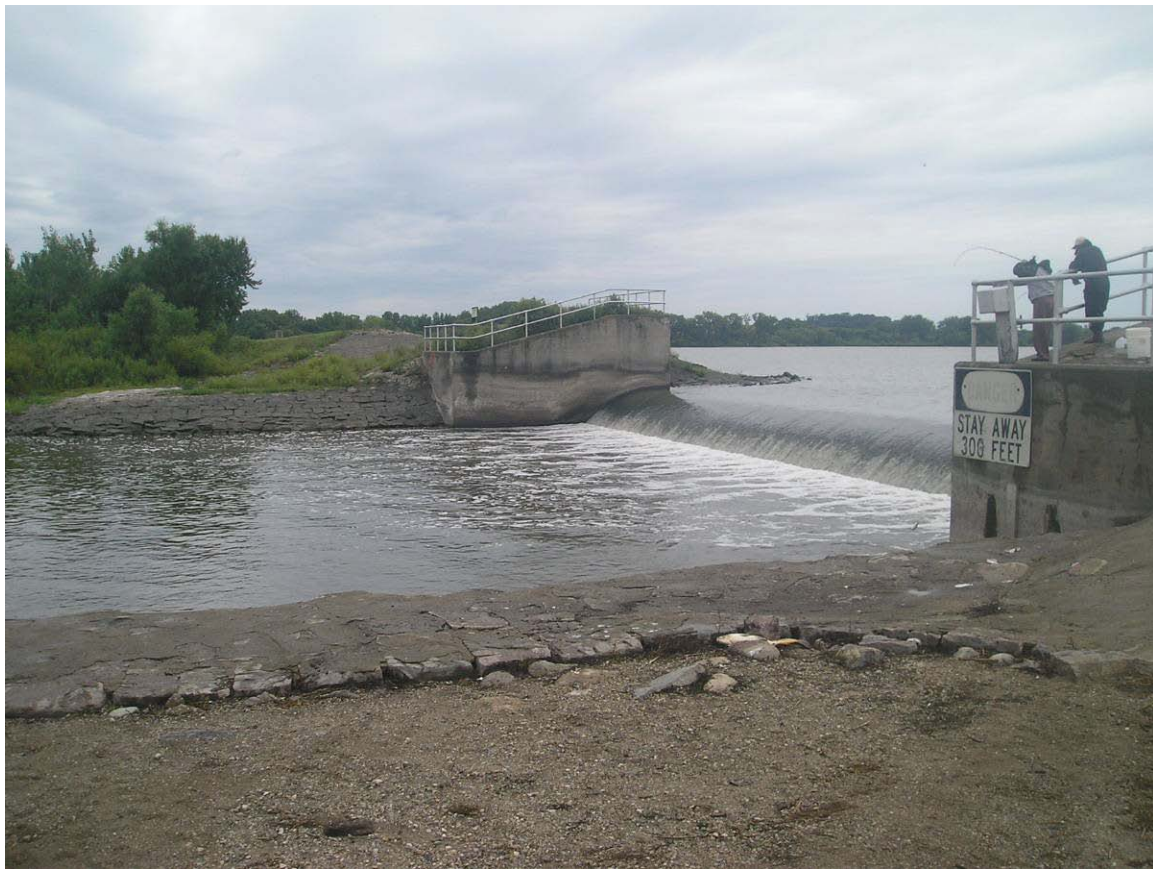
Figure 2-3. Marsh Lake Dam.
