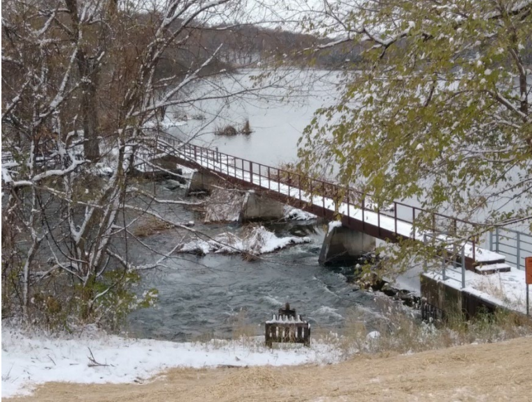
Figure 27. Lower Sakatah Lake Dam.
