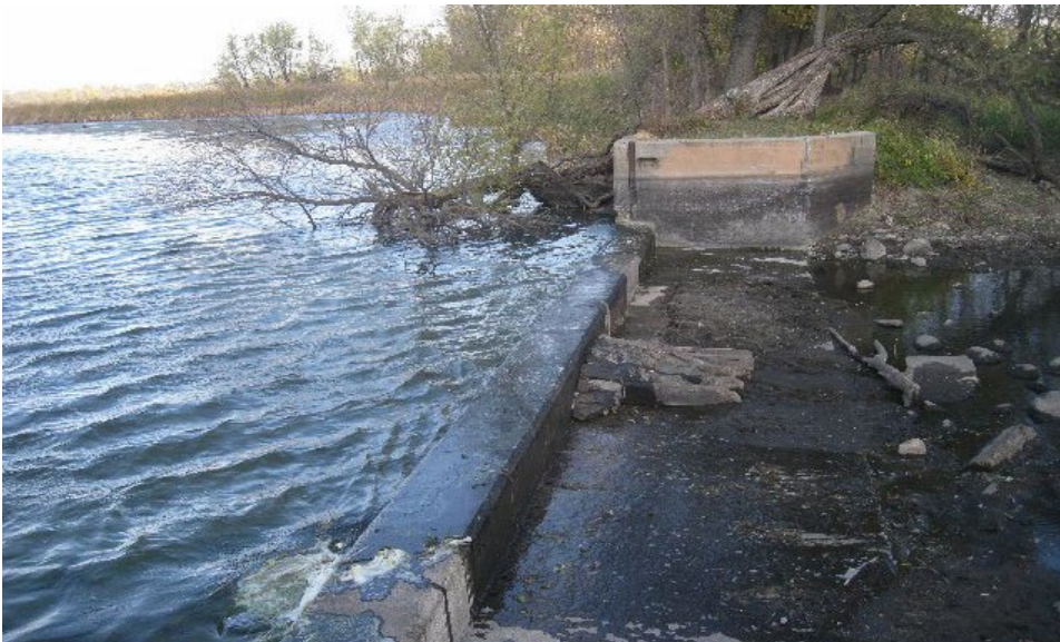
Figure 28. Gorman Lake Dam.
