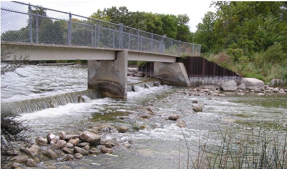
Figure 25. Pomme de Terre Lake Dam.
