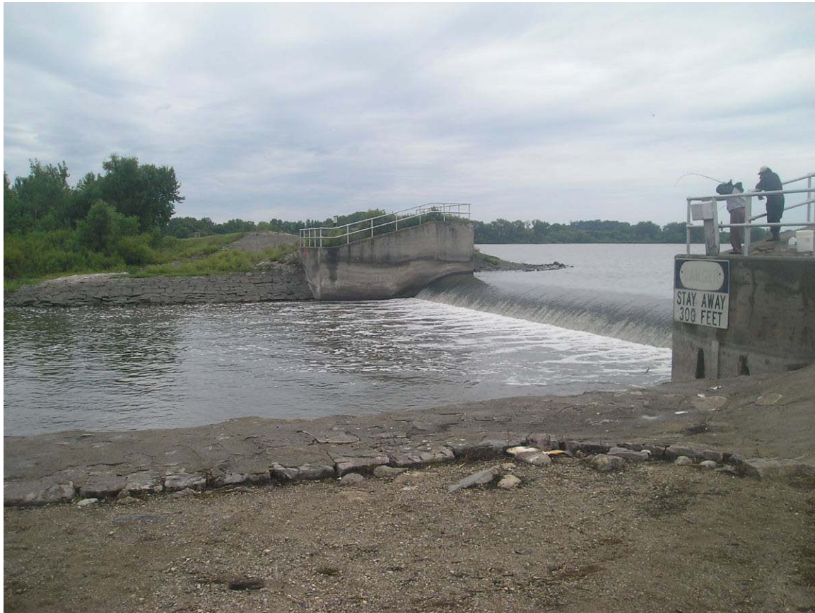
Figure 2-3. Marsh Lake Dam.
